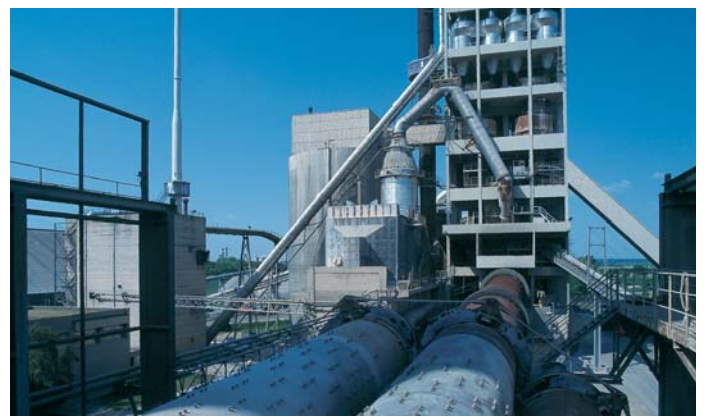
Die Brennstoffzufuhr bei Holcim klappt jetzt reibungslos.
