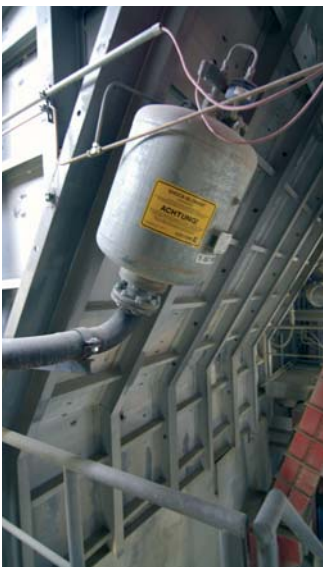
Über die Rohrleitungen (DN 100) mit Rundbögen gelangt die Druckluft der SHOCK-BLOWER® zu den Luftleitdüsen
