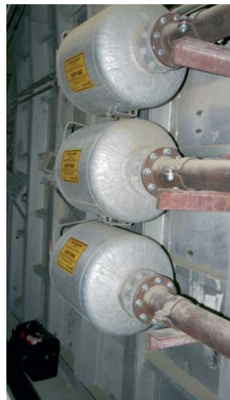
Über die Rohrleitungen (DN 100) mit Rundbögen gelangt die Druckluft der SHOCK-BLOWER® zu den Luftleitdüsen
