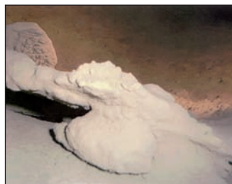
Ansatzbildung in einem Wärmetauschersystem.
